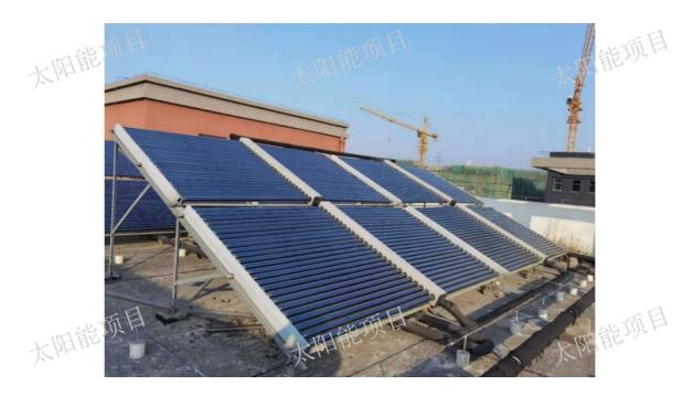
使用过程平板式太阳能热水器为顶水方式工作,真空管太阳能热水器也可实行顶水工作的方式,水箱内可以采用夹套或盘管方式。顶水工作的优点是供水压力为自来水压力,比自然重力式压力大,尤其是安装高度不高时,其特点是使用过程中水温先高后低,容易掌握,使用者容易适应,但是要求自来水保持供水能力。顶水工作方式的太阳能热水器比重力式热水器成本大,价格高。1. 温差控制集热循环太阳能热水地暖系统中有集热器温测器和水温感应器,集热系统吸收太阳能辐射后,集热管温度上升,当集热器温度和水箱温度水温差 t设定值时,检测系统发出指令,循环泵将中央热水器中的冷水输入集热器中,水被加热后再回到水箱中,使水箱内的水达到设定的温度。2. 地暖管道循环系统增加一台热水循环泵,通过控制器控制地暖管道循环。当水温达到设定温度时,自动启动地暖循环泵,使高温水通过地暖盘管在室内循环,从而使室内温度不断提高。当水箱水温低于某一设定值时,自动停止地暖管道循环泵。
